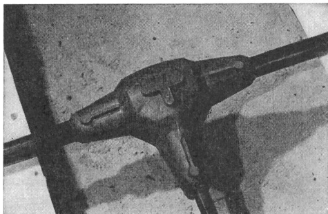
Montierte Hausanschlussmuffe
