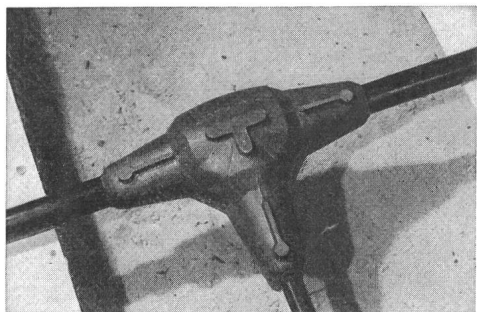
Montierte Hausanschlussmuffe
