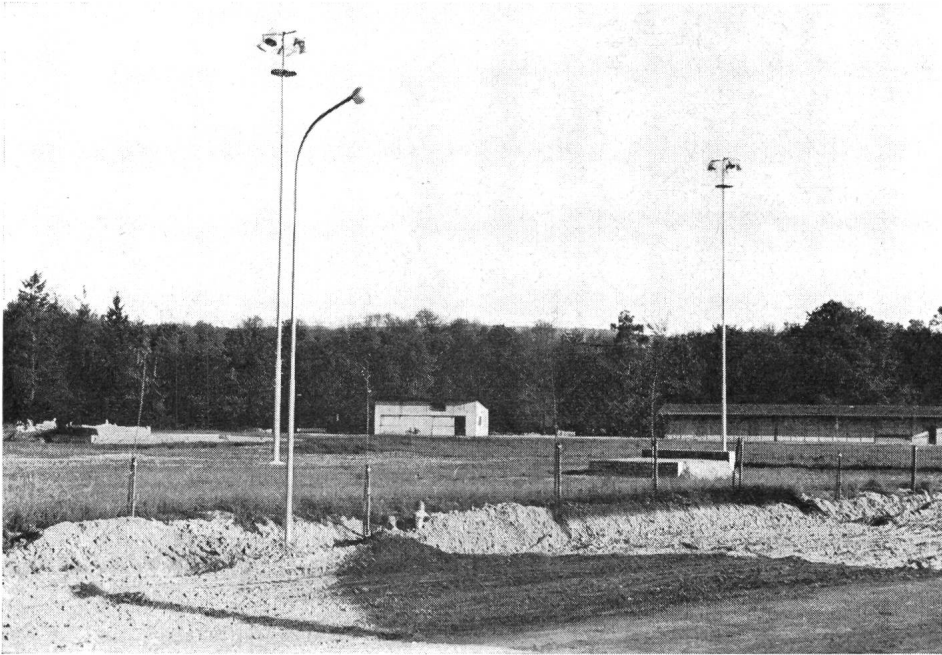
Scheinwerfermast, Höhe 24 m
