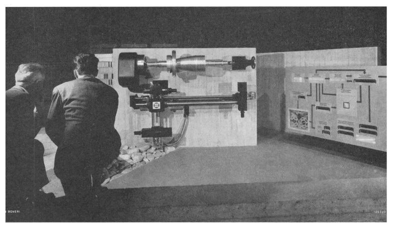
An der Expo 64 zeigt Brown Boveri ein Modell zur Demonstration einer elektrischen Stetigbahnsteuerung. Rechts Leuchtschaltbild für die Funktionsanzeige.
