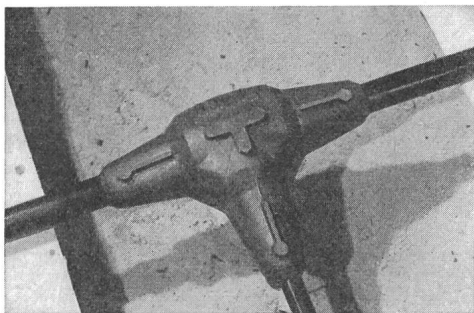
Montierte Hausanschlussmuffe
