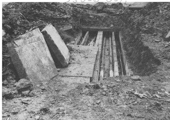
Fig. 1 Exemple de 2 caniveaux côte à côte
