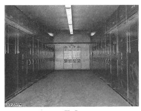
Fig. 7 Local 6 kV à l'arrière-plan, le tableau de commande et de signalisation de la partie 50 kV
