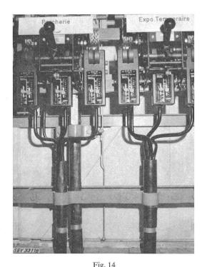
Détail montrant l'extrémité des câbles basse tension dans les postes de transformation de l'Exposition Nationale
