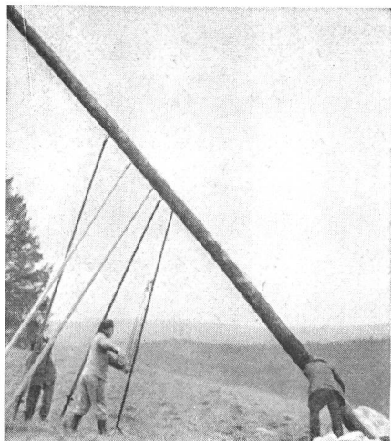
Leitungsbau im Kanton Bern mit LIFTY Stangenwinde
