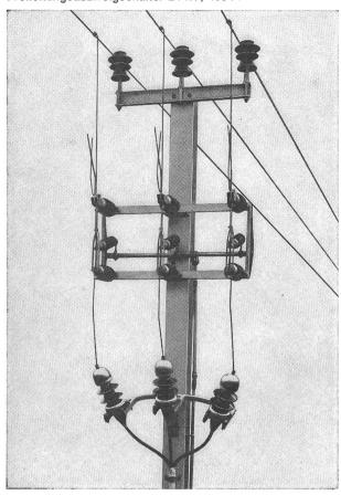
Sectionneur de dérivation 24 kV, 400 A
