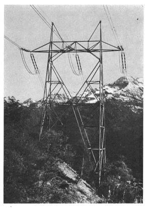
Abspannmast mit ausbetonierten Stahlrohren der 380-kV-Lukmanierleitung
