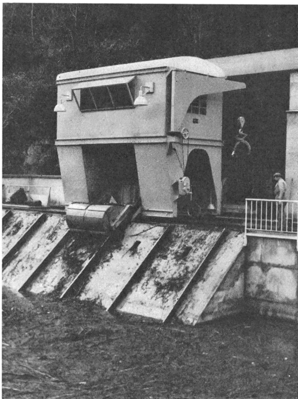
Dégrilleur de l'usine de Golin hac. (Massif central, France).
