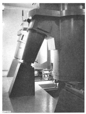
Fig. 20 150-kV-Kabelanschlüsse der 50-MVA-Einphasentransformatorgruppe 150/50 kV
