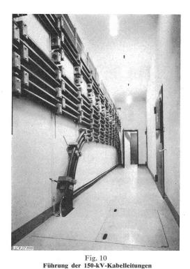
Führung der 150-kV-Kabelleitungen längs der Aussenwand im südlichen Quergang des Obergeschosses
