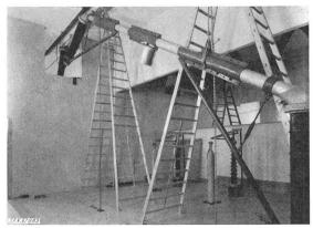
Fig. 13 Montage der Sammelschienen
