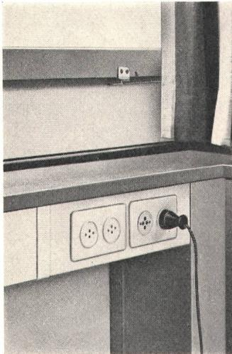
Teli-Flur, das Elektro-Installationssystem in Fußboden und Fensterbankkanal, ist der Träger aller Leitungswege für Stark- und Schwachstrom. Teli-Flur ermöglicht Anschlüsse an jedem beliebigen Punkt eines Raumes. Teli-Flur lässt sich auf Betonguss- wie auch in Stahl- oder andern Decken verlegen. Verlangen Sie unverbindlich den ausführlichen Teli-Flur-Katalog.
