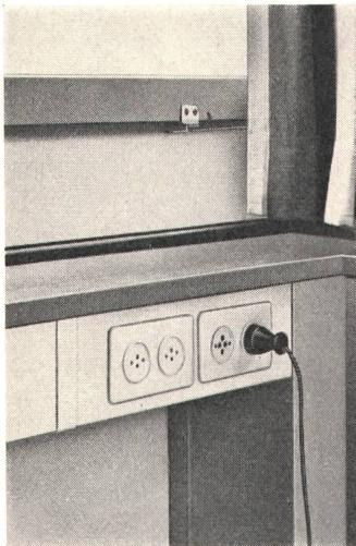
Teli-Flur, das Elektro-Installationssystem in Fußboden und Fensterbankkanal, ist der Träger aller Leitungswege für Stark- und Schwachstrom. Teli-Flur ermöglicht Anschlüsse an jedem beliebigen Punkt eines Raumes. Teli-Flur lässt sich auf Betonguss- wie auch in Stahl- oder andern Decken verlegen. Verlangen Sie unverbindlich den ausführlichen Teli-Flur-Katalog.
