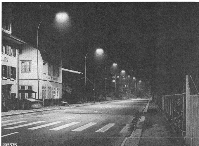
Fig. 10 Nachtaufnahme der Beleuchtung an der Seestrasse in Oberrieden (je Leuchte 2 \times 85 \text{ W} )
