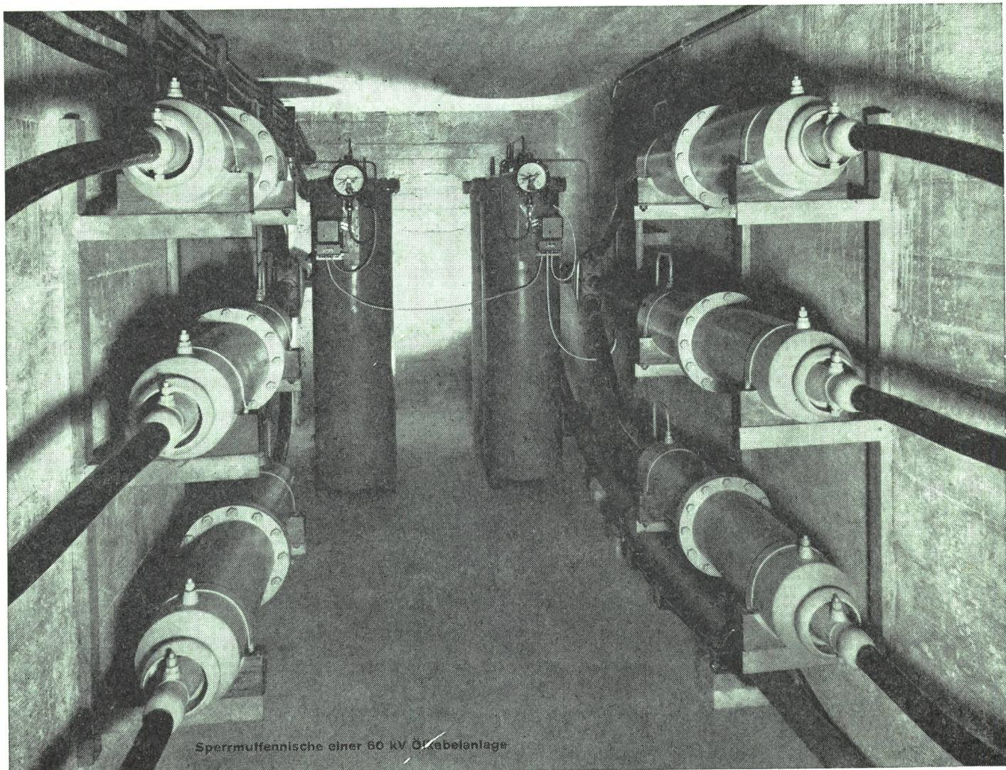
Sperrmuffenfläche einer 60 kV Öl-Kabelanlage
