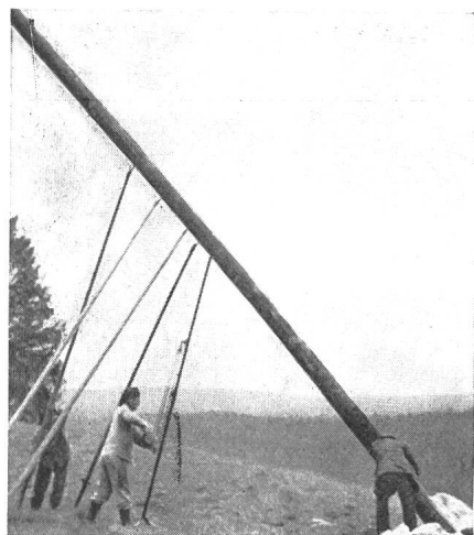
Leitungsbau im Kanton Bern mit LIFTY Stangenwinde
