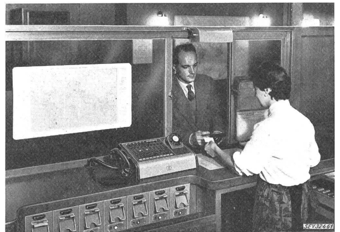
Fig. 11 Erste öffentliche Sprechstelle mit Gebührendruckern in der Hauptpost Winterthur
