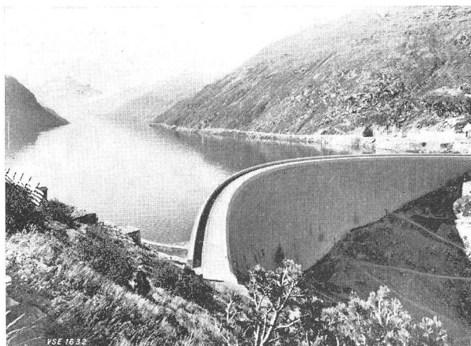
Fig. 1 Staumauer und Stausee Valle di Lei
