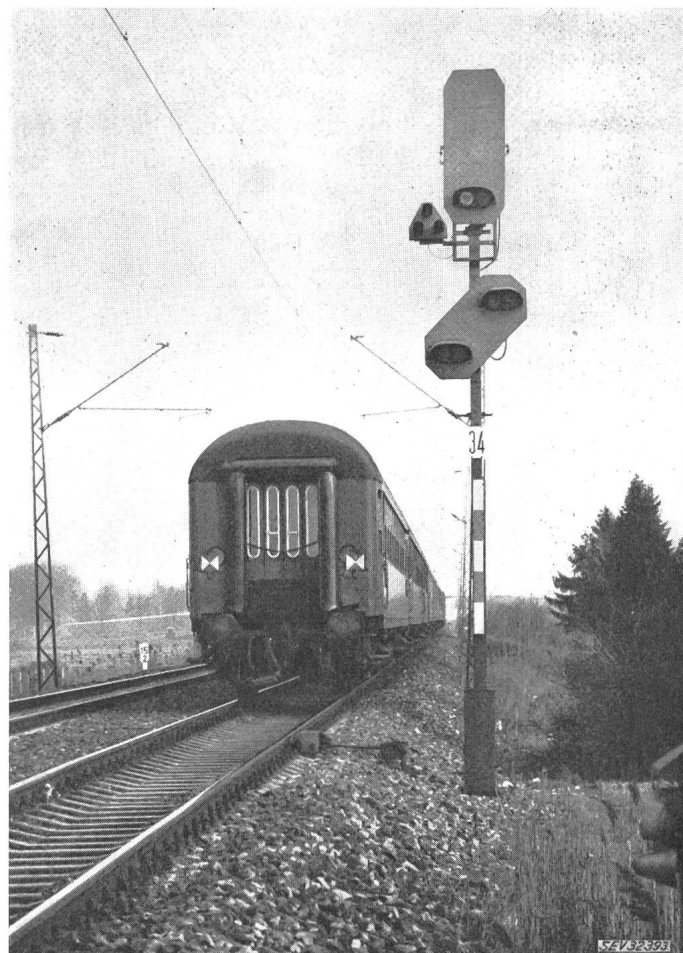
Fig. 2 Selbstblocksignal
