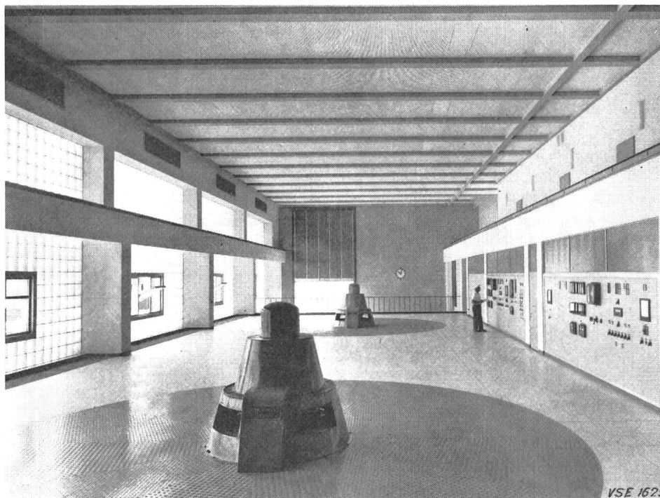
Kraftwerk Niederried-Radelfingen: Maschinensaal
