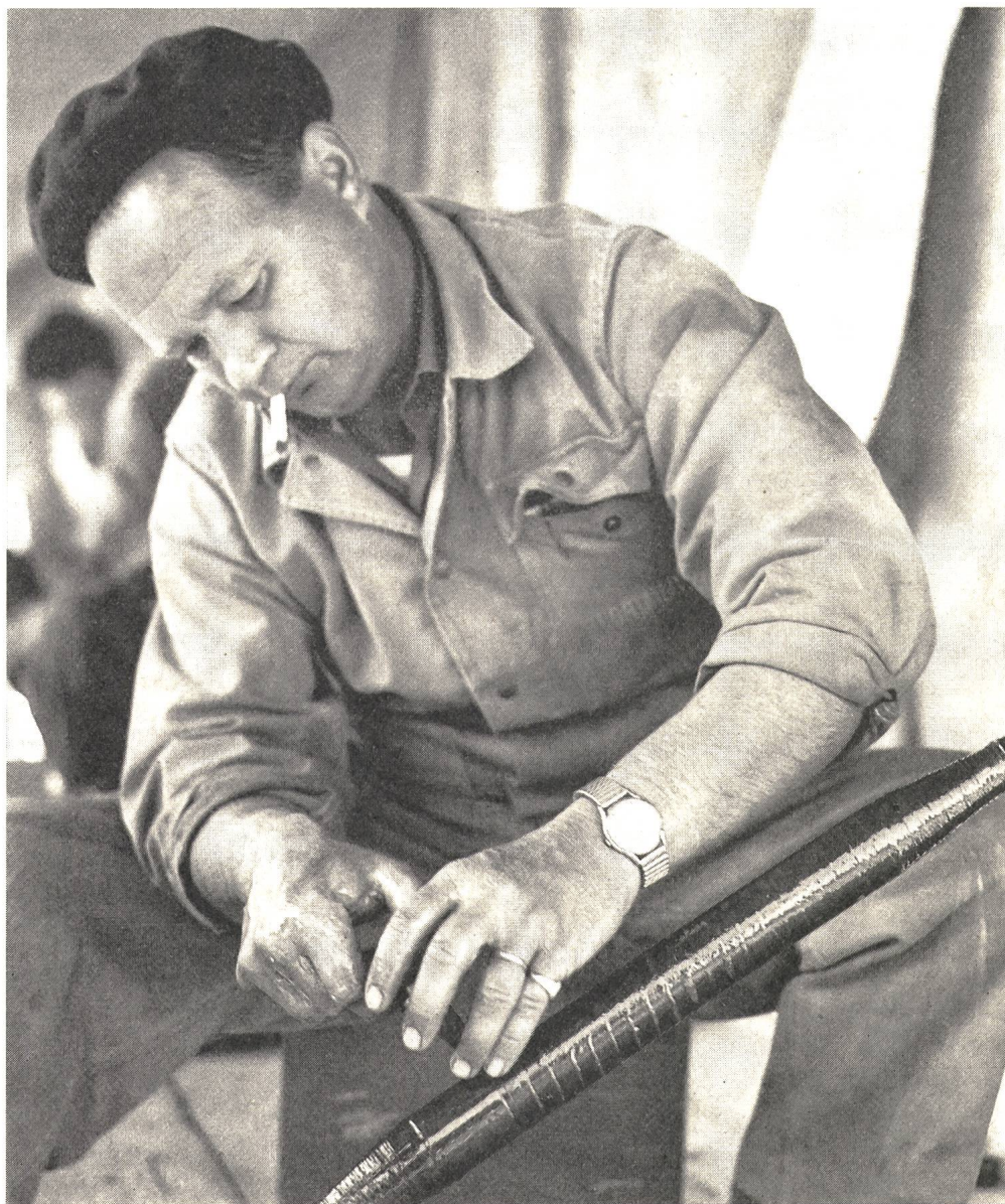
Fig. 15 Erstellung der Wickelkeule eines 50 kV-Kabelendverschlusses
