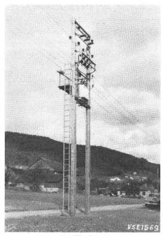
Fig. 2 Doppelholzmaststation mit Klappleiter
