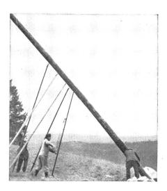
Leitungsbau im Kanton Bern mit LIFTY Stangenwinde
