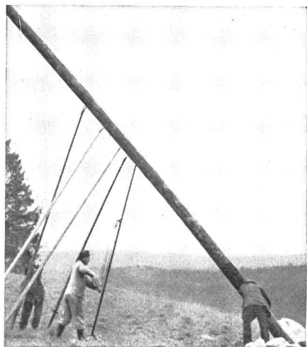
Leitungsbau im Kanton Bern mit LIFTY Stangenwinde
