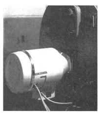
Fig. 1 Six-Madun-Ölbrenner an einem Industrieheizkessel für 750 000 kcal/h Wärmeleistung
