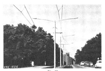
Fig. 10 Beleuchtungsmasten mit Auslegern für die Strassenbahn
