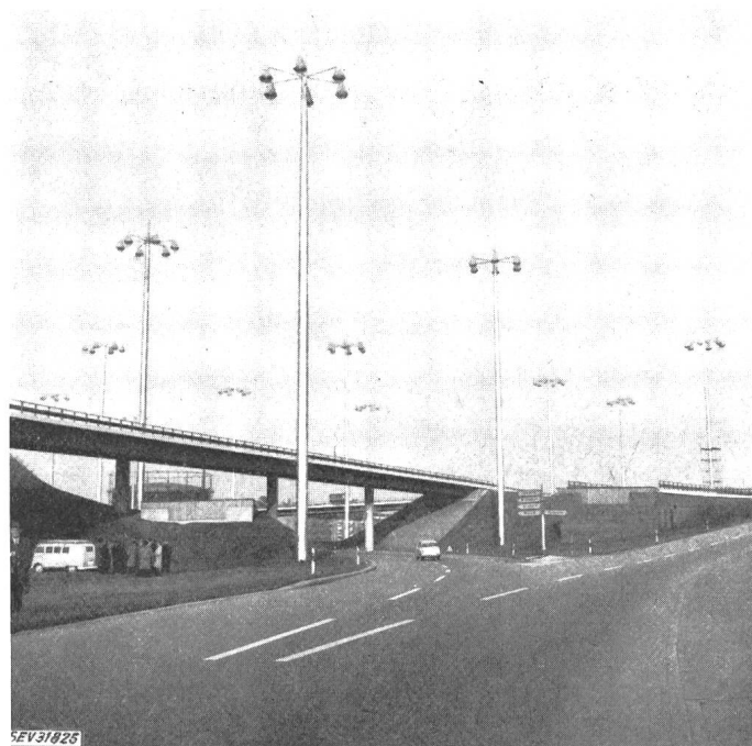
Fig. 3 Beleuchtungsanlage des Heerdter-Verkehrs-Dreiecks in Düsseldorf mit Hochmasten
