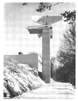
Fig. 3 Gebäude und Antennenturm des Luftstrassenradars auf Lägern Zu oberst die sich drehende Antenne von 3,4 m Höhe und etwa 12 m Durchmesser
