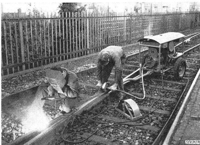
Fig. 8 Fahrbare benzinelektrische Schweissgruppe mit angeschlossener flexibler Welle und Schleifscheibe
