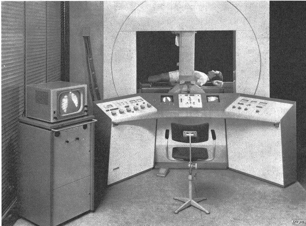
Fig. 7 Röntgenuntersuchungsplatz mit ferngesteuertem Untersuchungsgerät und Television
