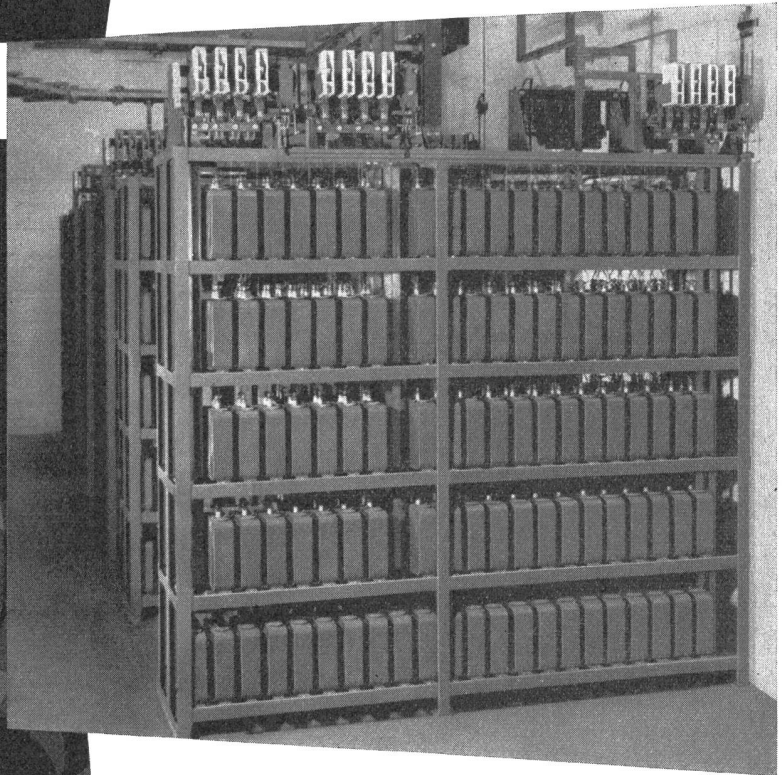
Teilansicht einer vollautomatischen Kondensatorenanlage in einer Grossgiesserei
