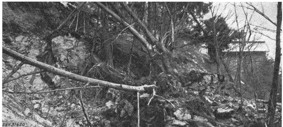
Fig. 5 Westlicher Anriss und Schieberhaus
