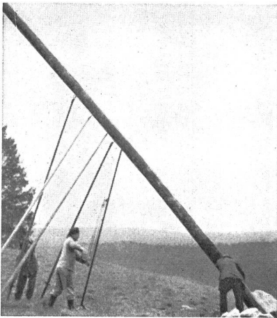
Leitungsbau im Kanton Bern mit LIFTY Stangenwinde
