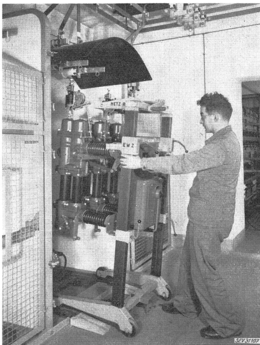
Fig. 1 Die in den Zellen festmontierten ölarmen Schalter werden für die Revision ausgefahren
