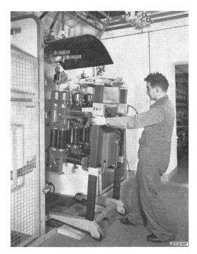
Fig. 1 Die in den Zellen festmontierten ölarmen Schalter werden für die Revision ausgefahren
