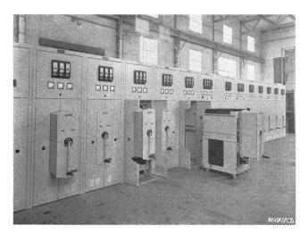
Fig. 22 Gekapselte Schaltanlage mit ölarmen Schaltern
