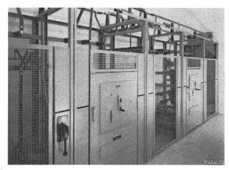
Fig. 21 Schaltanlage in offener Bauweise mit ölarmen Schaltern, Typ MS 24.6
