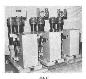
Ölstrahlschalter Typ HP 6g
