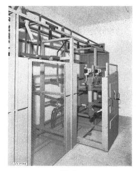
Fig. 20 Ölarmer Schalter Typ MS 24.6 mit Schalterwagen
