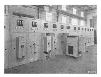
Fig. 22 Gekapselte Schaltanlage mit ölarmen Schaltern
