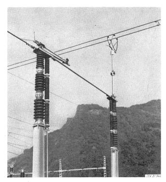
Fig. 6 1-Säulen-Trenner (Pantograph) 245 kV, je in offener und geschlossener Stellung
