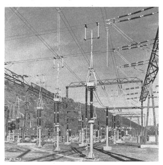
Fig. 5 1-Säulen-Trenner (Pantograph) 245 kV, in geschlossener Stellung, mit festem Bügel am darüber hängenden Seil
