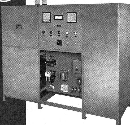
Gleichrichter für Elektrolyseur mit umschaltbarer Spannung 12 V 24 V und Konstantstrom-Regulierung 2000/1000 A, mit ölgekühltem Selen-Element.
