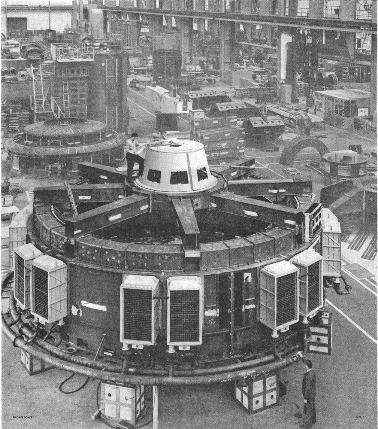
Stator eines der drei 60-MVA-Wasserkraftgeneratoren, 13800 V, 60 Hz, 106 U/min, für die Zentrale Wilson Dam der Tennessee Valley Authority, Knoxville (USA)
