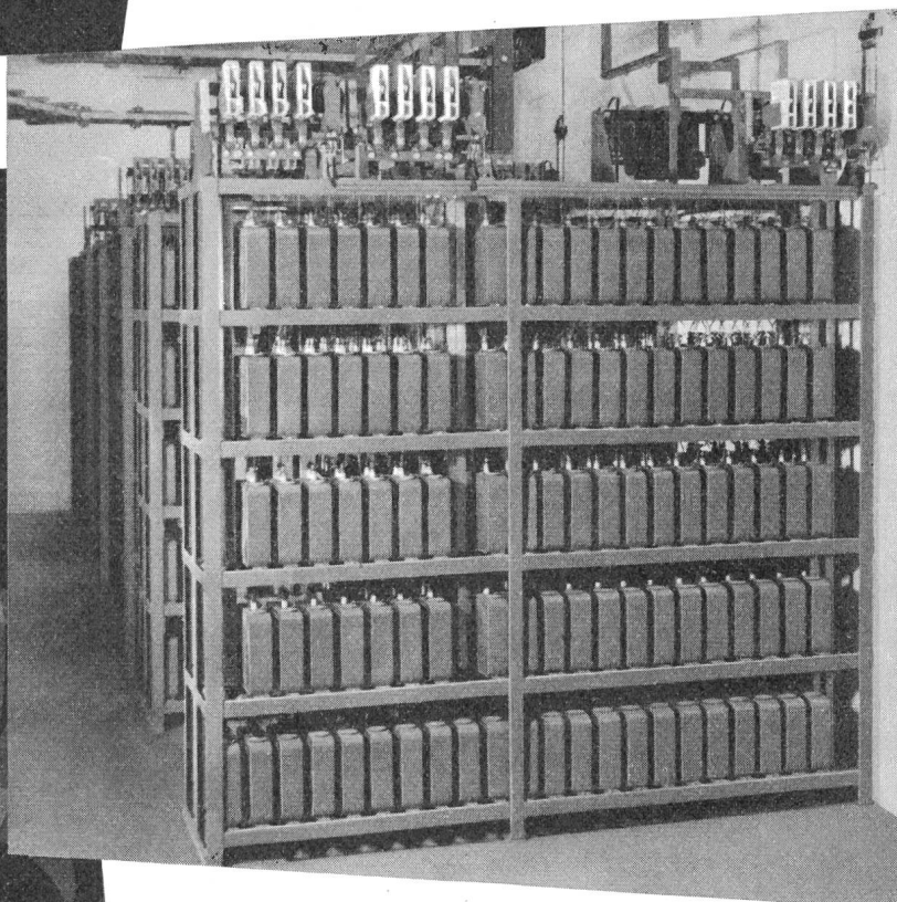
Teilansicht einer vollautomatischen Kondensatorenanlage in einer Grossglasserei
