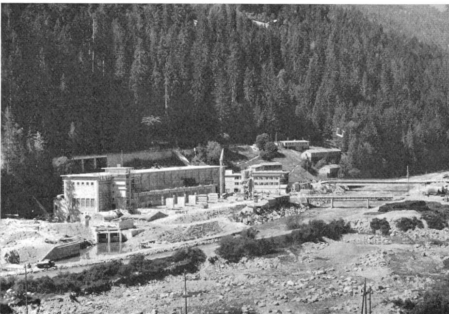
Von den Generatoren fließt die Energie über die Generatorenschaltanlage zu den auf der Flußseite des Maschinenhauses im Freien aufgestellten Transformatoren. Es sind 7 einzelne Transformatorpole installiert, von denen 6 zu 2 dreiphasigen Gruppen zusammengeschaltet sind. Der dazwischen stehende Reservepol kann elektrisch an Stelle jedes in Betrieb stehenden Poles geschaltet werden, ohne den Platz zu wechseln. Aus Platzgründen sind die Transformatoren mit Wasserkühlung versehen, deren Kühler frostsicher im Untergeschoss des Maschinenhauses aufgestellt sind. Jede Transformatoren-
