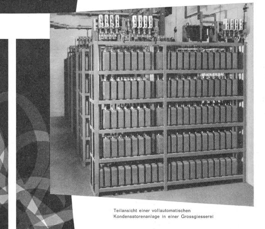
Kondensatoren reduzieren durch Kompensation des Blindstromverbrauchs Ihre Stromrechnung und bieten zusätzlich die Möglichkeit, Ihre Anlage besser auszunutzen. Die einmaligen Anschaffungskosten sind innert kurzer Zeit amortisiert.
