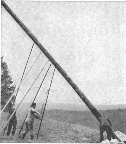
Leitungsbau im Kanton Bern mit LIFTY Stangenwinde
