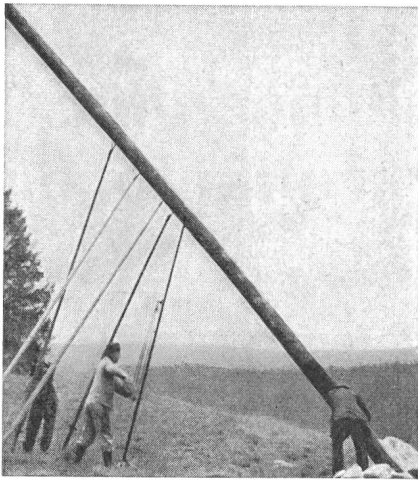
Leitungsbau im Kanton Bern mit LIFTY Stangenwinde
