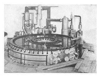
Fig. 5 Vue d'une installation d'imprégnation de câbles à masse
