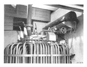
Fig. 12 Transformator der MFO mit einem Expansionsgefäss, in welchem der Ölspiegel durch eine Gummimembran abgeschlossen ist
