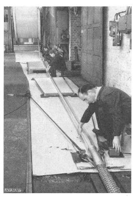
Fig. 7 Einziehen des Innenleiters eines Antennenspeisekabels
