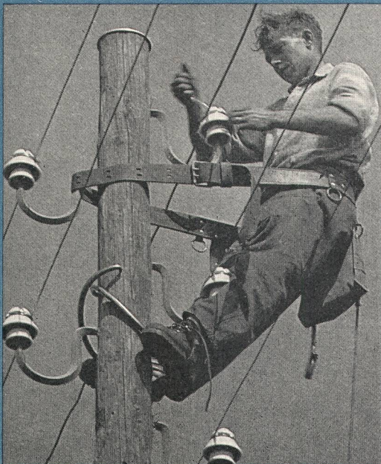
❸ Arbeit an einer 16 kV-Leitung
