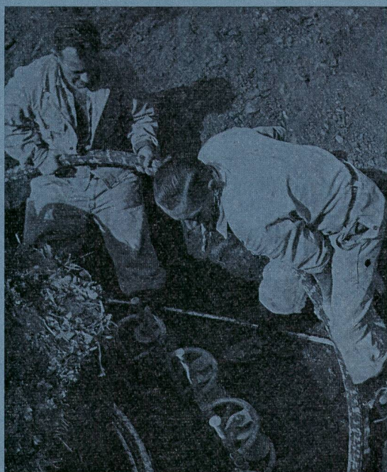
③ Nachzug eines Verteilkabels
