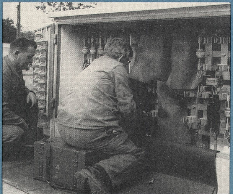
❹ Störungsbehebung in einem Verteilkasten
