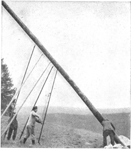
Leitungsbau im Kanton Bern mit LIFTY Stangenwinde
