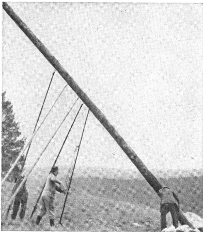
Leitungsbau im Kanton Bern mit LIFTY Stangenwinde
