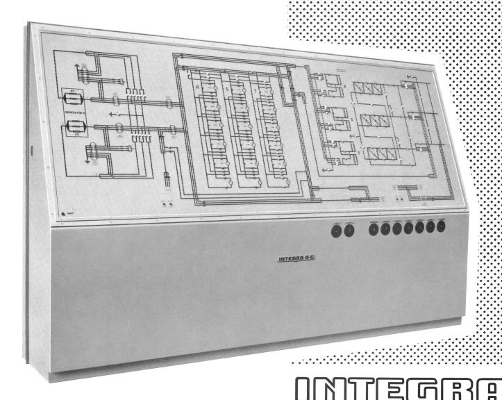
Kommandoapparat der Schaltanlage in einem Versuchslokal der Firma Brown Boveri AG Baden
