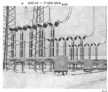
Ölarmer Leistungsschalter Typ HPF 516 in Kilforsen, Schweden Im Jahre 1952 wurde der Sprecher & Schuh ölarme Leistungsschalter als erster Schalter mit Öl als Löschmittel in einem 420 kV-Netz geprüft und in Betrieb genommen.
