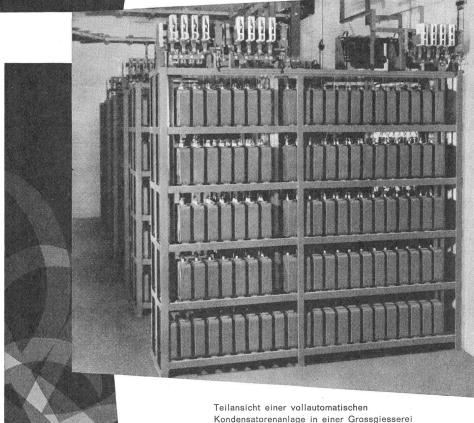
Kondensatoren reduzieren durch Kompensation des Blindstromverbrauchs Ihre Stromrechnung und bieten zusätzlich die Möglichkeit, Ihre Anlage besser auszunutzen. Die einmaligen Anschaffungskosten sind innert kurzer Zeit amortisiert.
