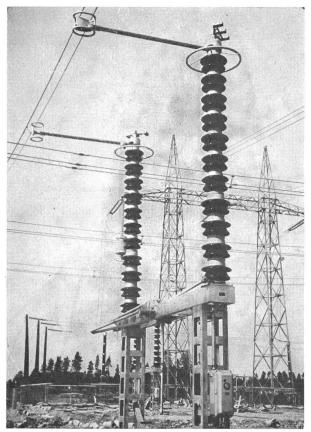
Trennschalter 420 kV 1600 A mit Motorantrieb u. Erdungsschalter
