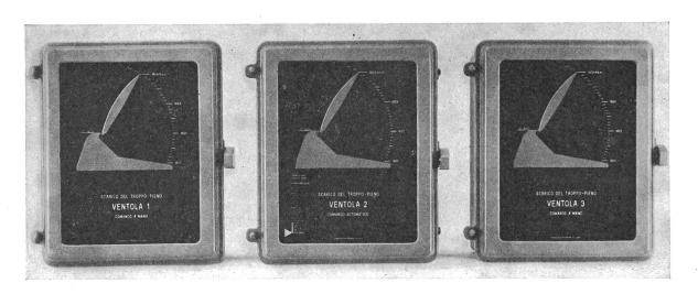
Misoxer Kraftwerke AG - Staumauer Isola Hochwasserentlastungsklappen 3 Stellungsindikatoren
