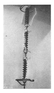
Fig. 6 Hängeketten mit Gabelringarmaturen
